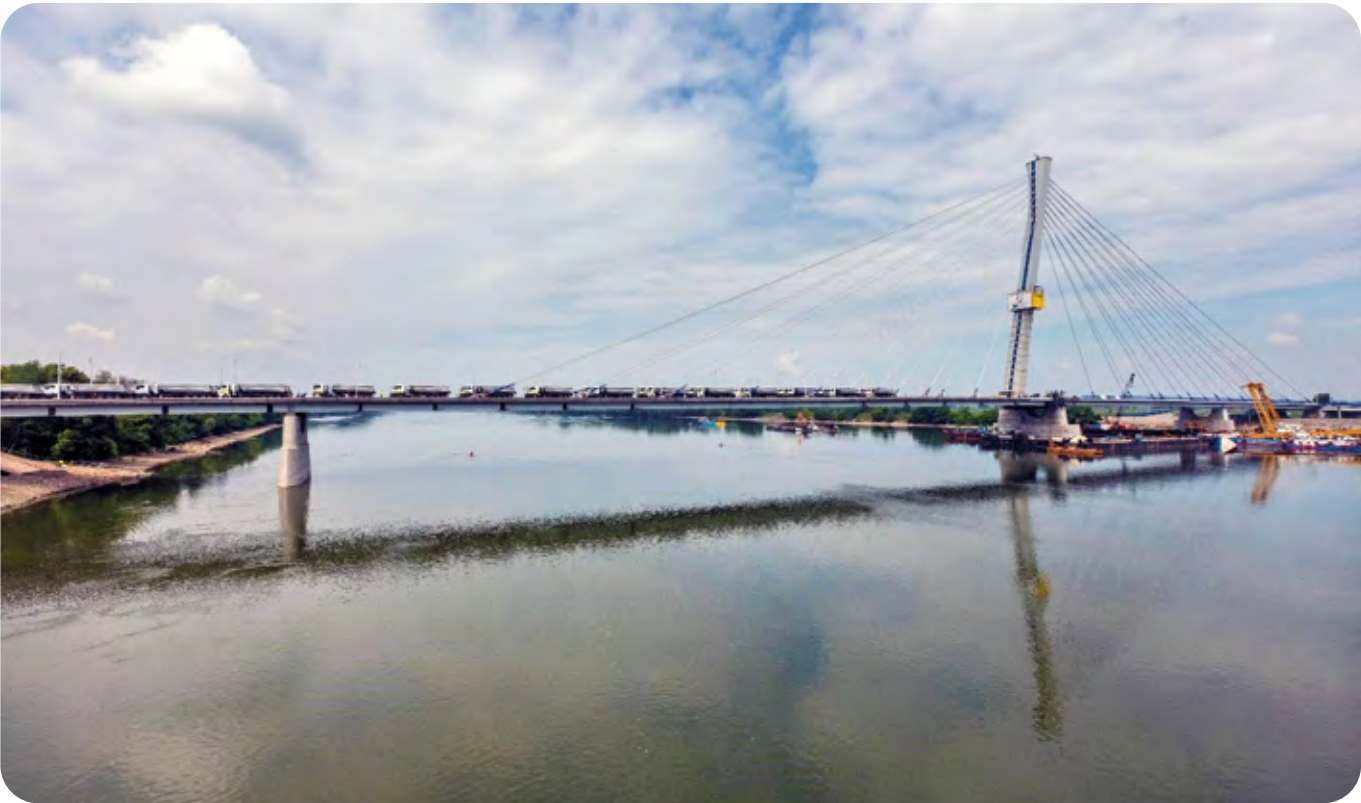
5. ábra: Az új komáromi Duna-híd próbaterhelés közben
